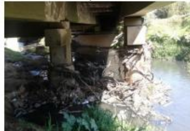
Foto 42 Pilares da ponte da Nova Dutra
