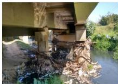
Fig.3 - Ponte sobre o rio Queimados
