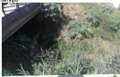
Foto 7 Ponte sobre o rio Sarapó.Div. N.I Sarapó
