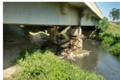
Fig.4 - Ponte sobre o rio Queimados
