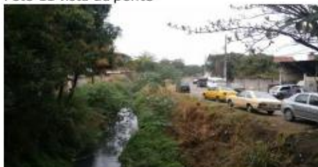
Foto 11 vista da ponte
