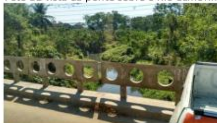
Foto 12 vista da ponte sobre o Rio Camorim
