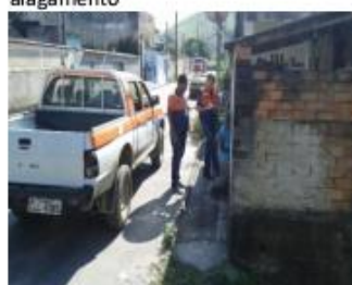
Foto22 casa com batente para evitar alagamento
