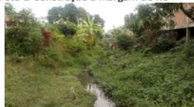
Foto 2 construção à margem do rio
